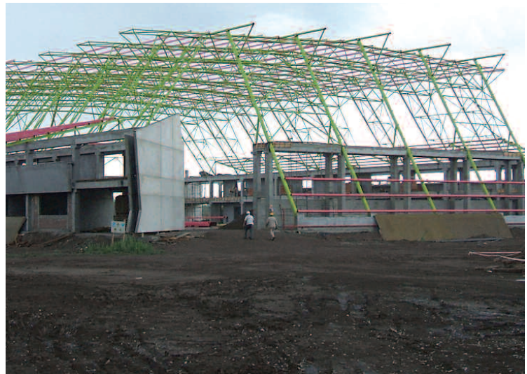
Construcción Polideportivo General Alvear.
