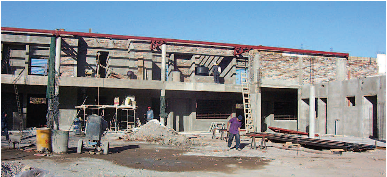
Construcción Escuela Grosso - Guaymallén.
