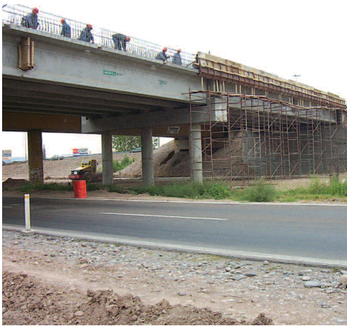
Construcción puente de calle Paso sobre Ruta Nacional 40.
