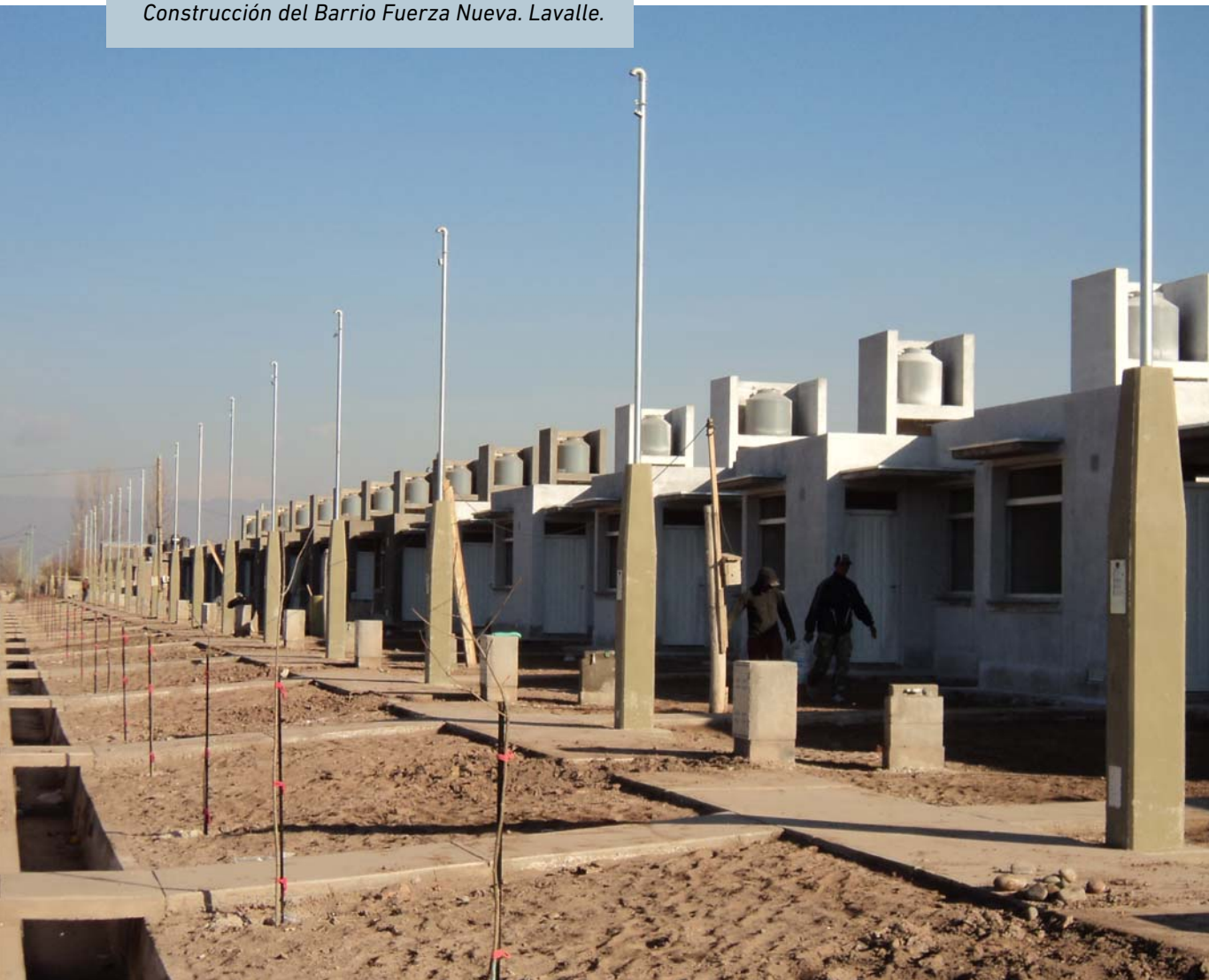
Auditorías de obras públicas. Construcción del Barrio Fuerza Nueva. Lavalle.
